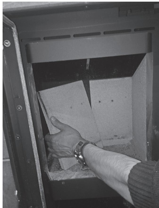
Das Wiedereinsetzen der Feuerraumauskleidung erfolgt in umgekehrter Reihenfolge.
